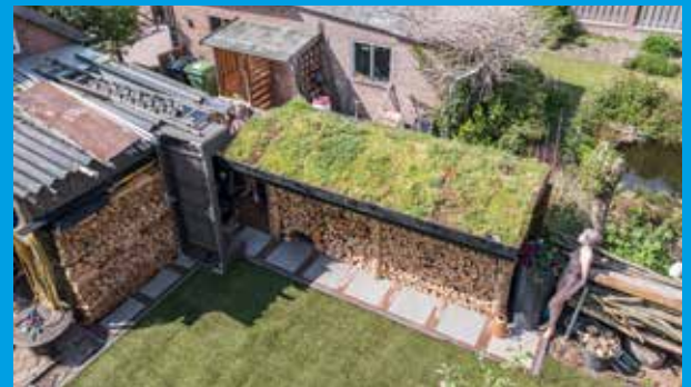
Een groen dak heeft veel voordelen: geeft koeling, houdt regenwater vast en zorgt voor biodiversiteit
