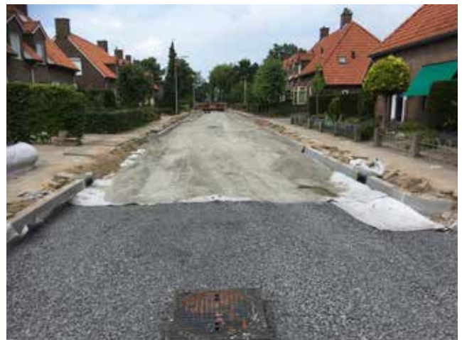
Een pakket van steenslag onder de straat. Tussen deze stenen kan veel regenwater worden geborgen
