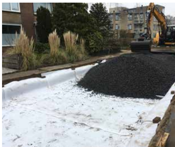
Infiltratie en tijdelijke waterberging onder de rijbaan van een straat
