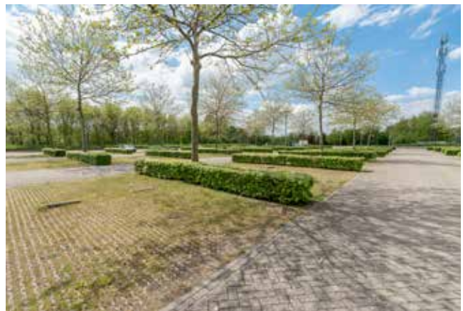
Waterdoorlatende bestrating voorkomt wateroverlast en uitdroging van de bodem
